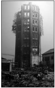
関東大震災でこわれた建物 （東京 浅草・1923年） 写真：作者不明 （パブリックドメイン）。 Wikimedia Commons より、 白黒にして切り取った
