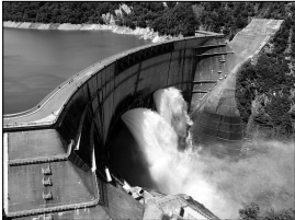
水力発電のダム（黒部ダム） ためた水の位置エネルギーで発電 写真：Raki_Man（CC BY 3.0）。 Wikimedia Commons より、 白黒にして名前を加えた
