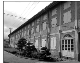
富岡製糸場 （群馬県富岡市）
