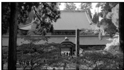
延暦寺の根本中堂 （滋賀県大津市）
