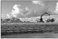
国土を守るための埋め立て工事 （ツバルのフナフティ）
